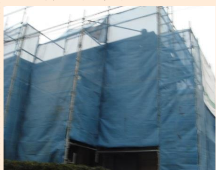
【足場架設中の大野様邸】
