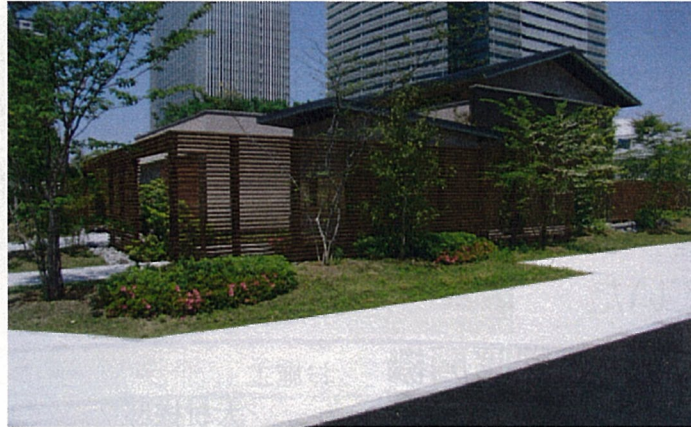
新高島駅のビルの中にある一戸建て住宅
