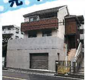
地下車庫はコンクリートでシンプルに上には家も完成しました！！
