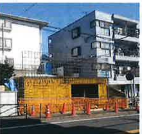
地下車庫部分の形が見えて来ました。コンクリートが固まるのを待ちます
