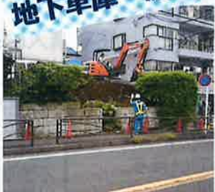
いよいよ工事着工重機が入りまず地下車庫から造ります
