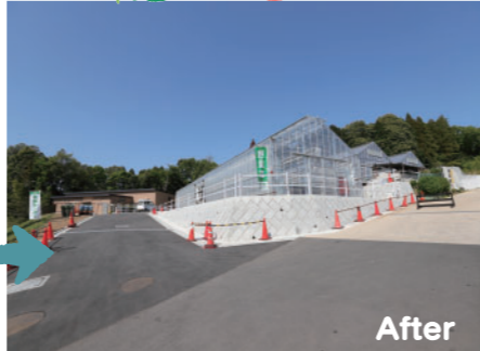
▲入り口から見た管理棟とビニールハウス
